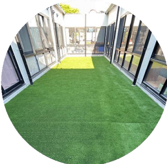
工事完成後の中庭 裸足でも遊べるようになりました
